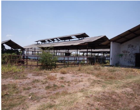
a. Kondisi bangunan secara umum
