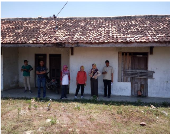
e. Unit bangunan mess karyawan belakang
