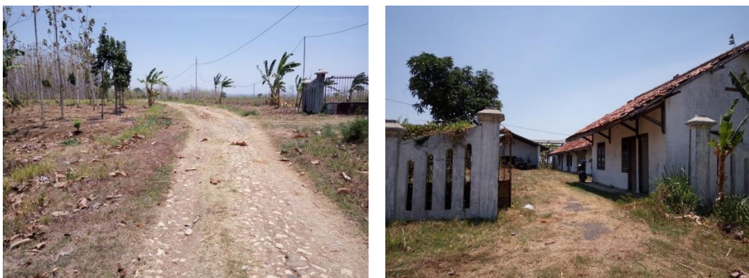
Gambar 5.1 Kondisi jalan akses menuju kawasan
